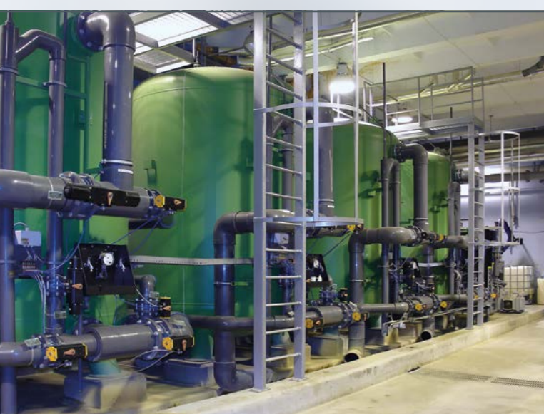
Adsorbants traversés en continu dans une station de traitement de l'eau
