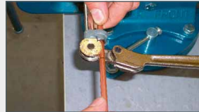
Einlegen des Rohres in die Biegevorrichtung
