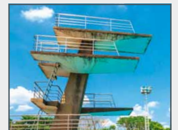
Carga por flexión en una viga tensada en un punto en el ejemplo de un trampolín
