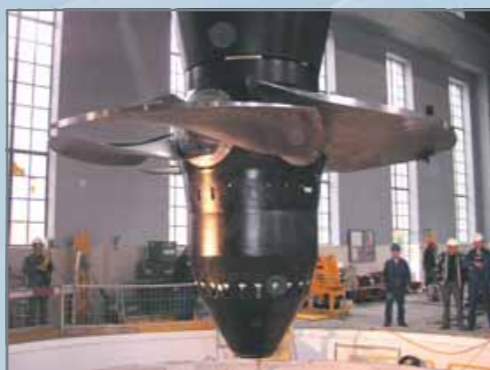
Montage d'une turbine Kaplan
