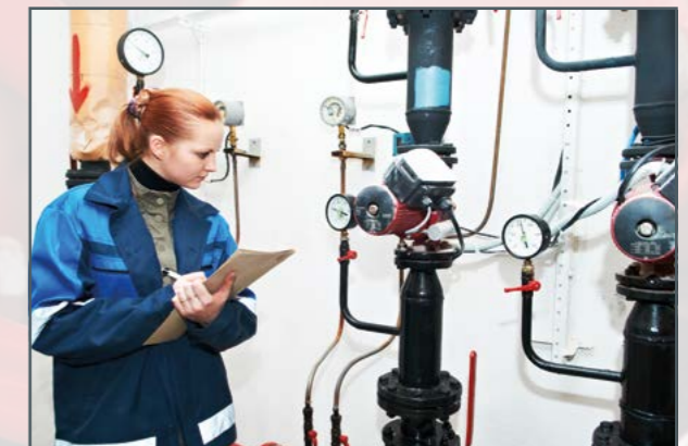
Controles de los componentes de la instalación
