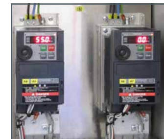
Convertisseurs de fréquence pour contrôler les pompes
