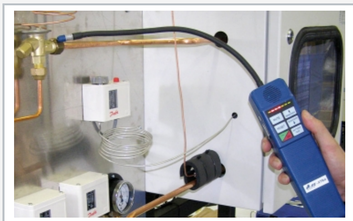
Prueba de estanqueidad en la válvula de expansión de la instalación completamente montada
