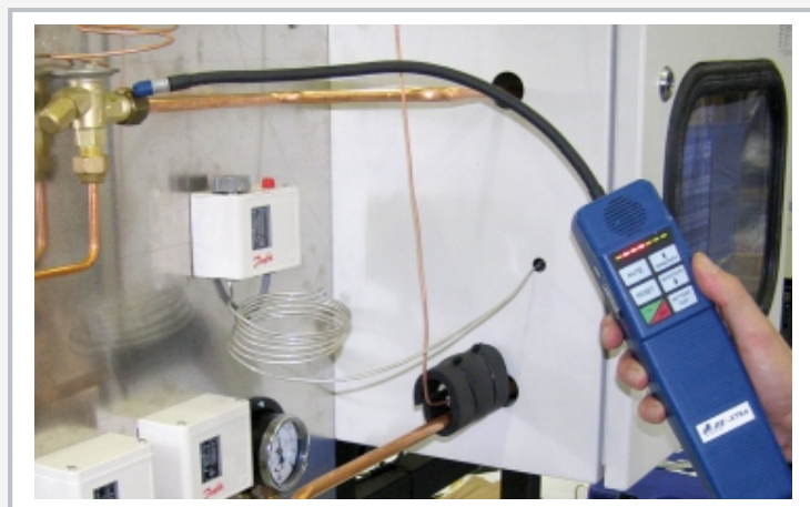
Dichtigkeitsprüfung am Expansionsventil der fertig montierten Anlage
