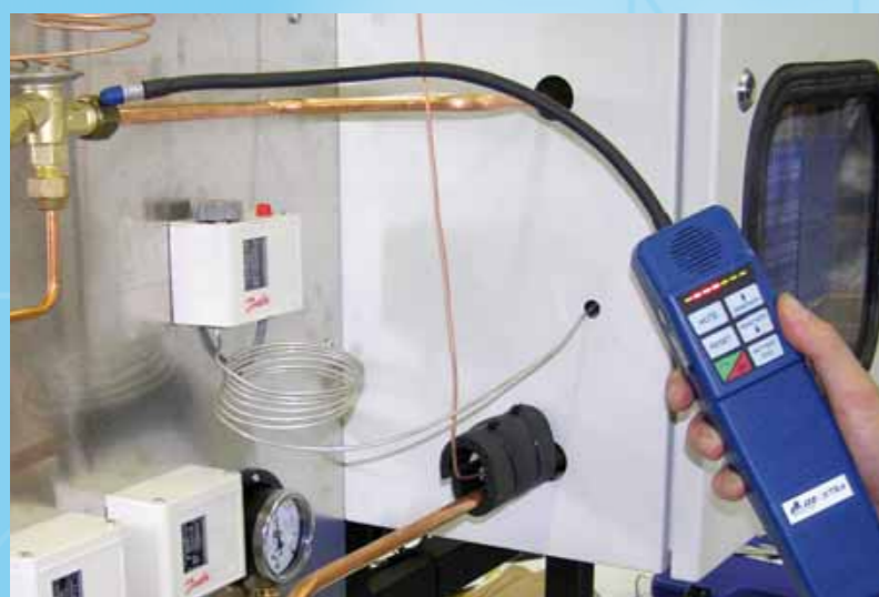
Test d'étanchéité au niveau du détendeur
