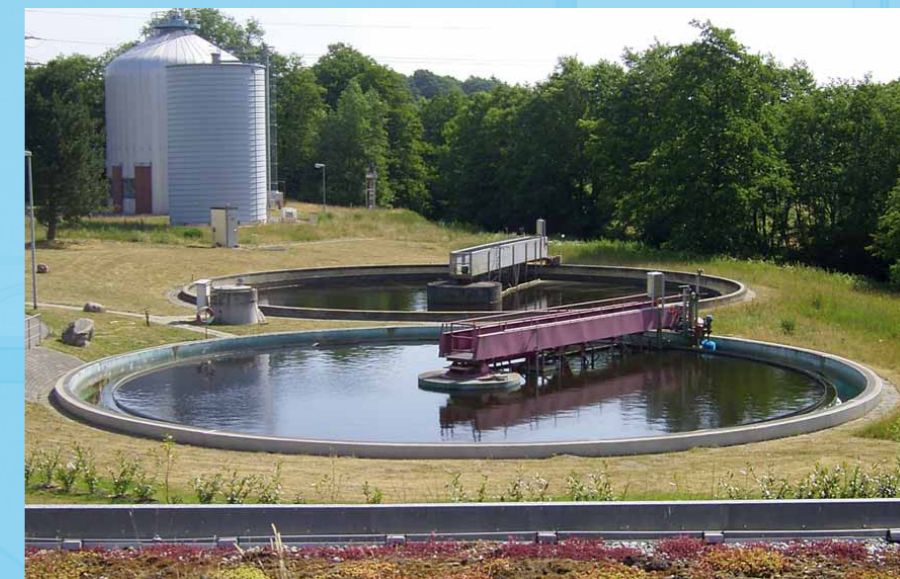
Décanteur secondaire
